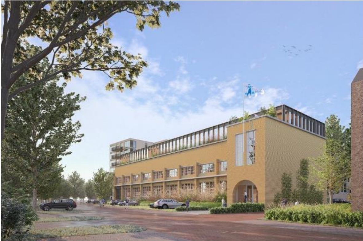
Het monumentale Du Crocq-gebouw krijgt een extra verdieping, die vanaf de straat nauwelijks is te zien.
